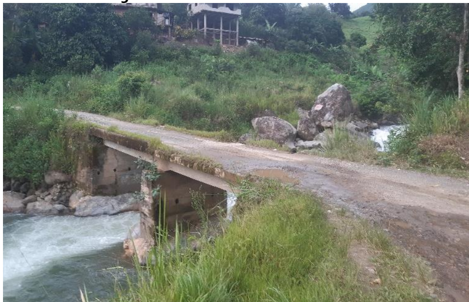
Figura 15 Puente de Ortega
